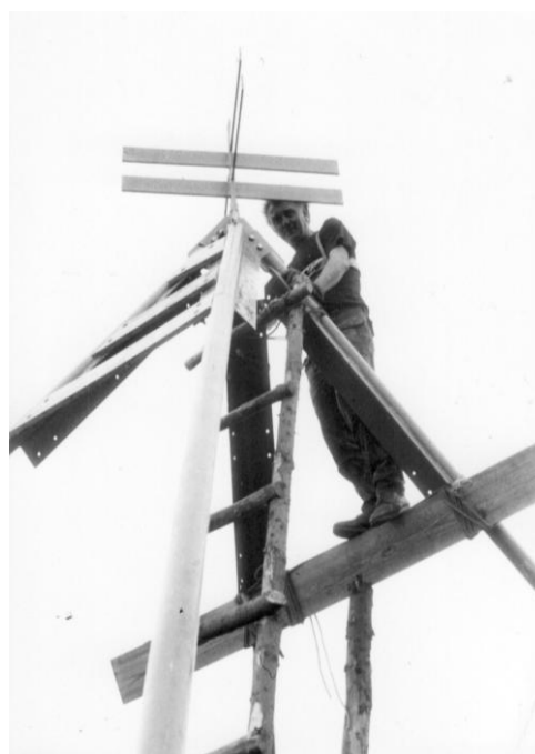
Prace montażowe na szczycie Baraniej Góry w dniach 22.07. – 13.08. 1991 r.
